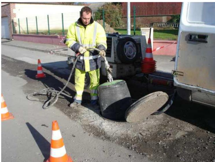
Figure 3 - Opération d'obturation d'une portion de réseau
